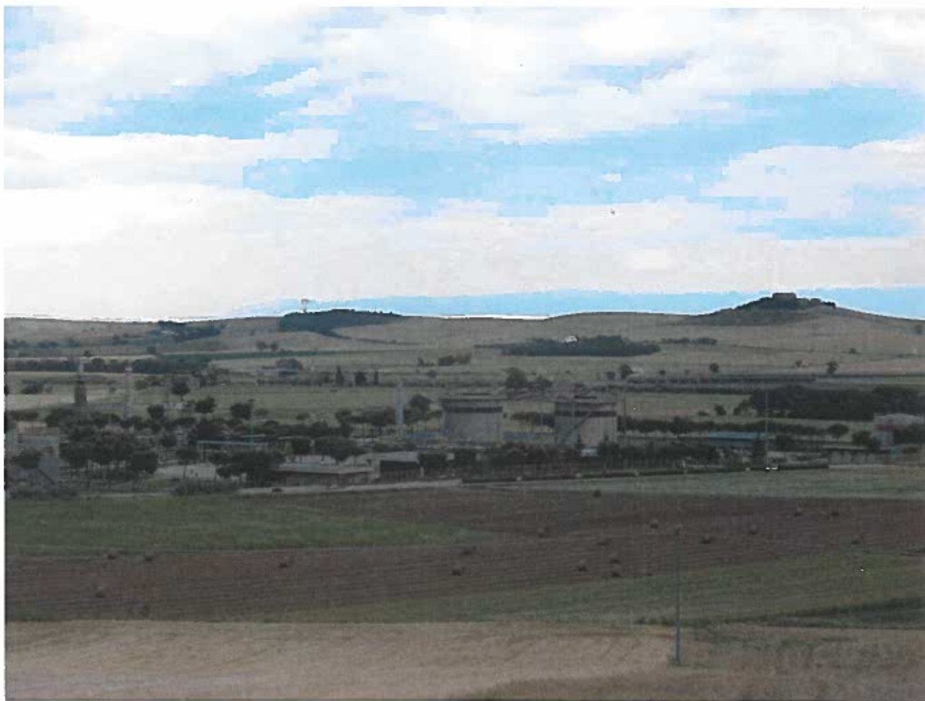
Centrale “Torrente Tona”
