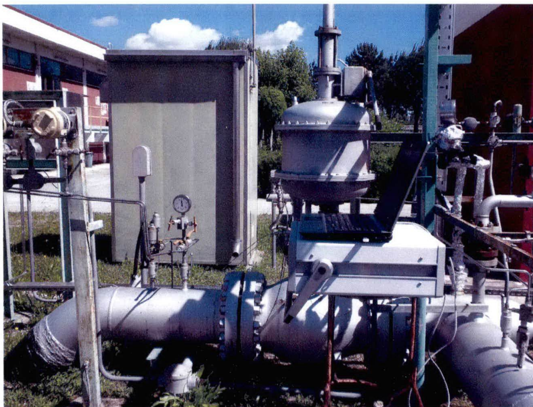
Linea di adduzione alla rete SNAM e gascromatografo portatile modello \mu GC 3000 della Agilent
